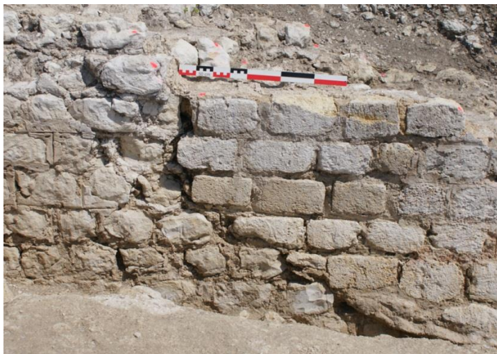
Fig. 38 : Réparation en pierre de Marcamps dans le secteur 9 (fouilles J. Mousset - cl. J. Gaillard)
